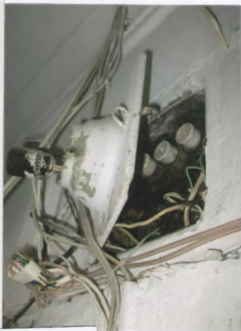
СТАН ЕЛЕКТРОДИ НА III ПОВЕРСІ II ПІД'ІЗДУ: ЗОВНІШНІ АВТОМАТИЧНІХ ВИБІВКАЧІВ - 'ПРОБКИ' (1 ПОКЕТ)
