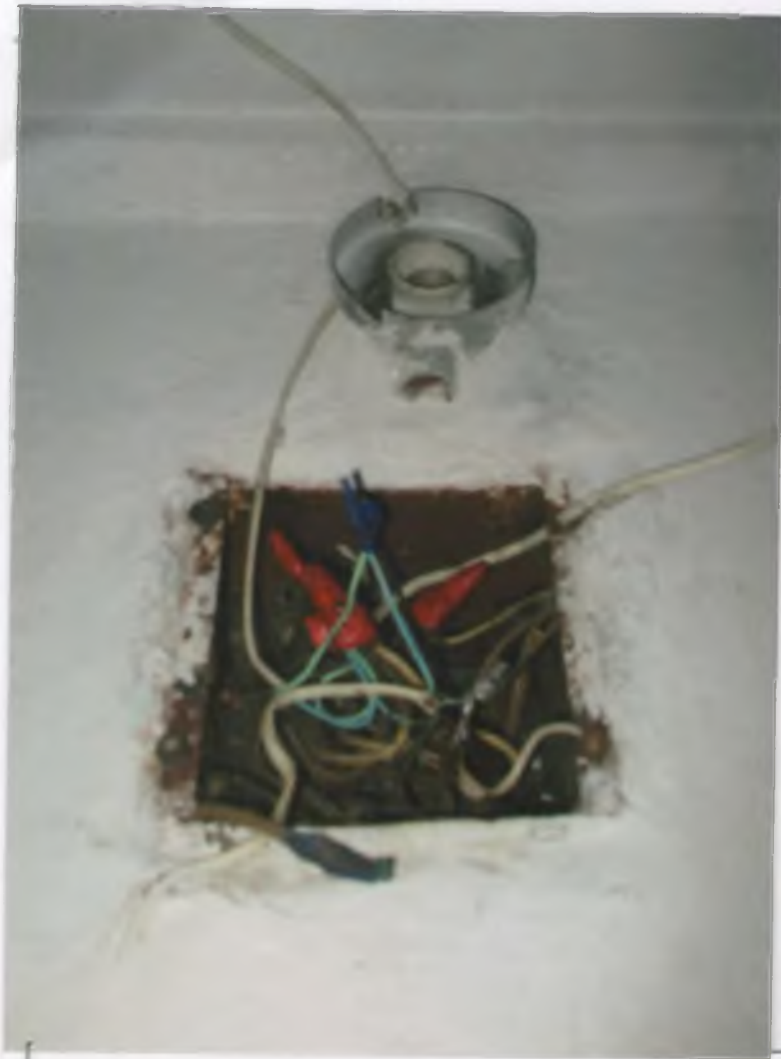
СТАН ЕЛЕКТРОДИ ТА СВИТІЛЬНИК НА I ПОВЕРСІ II ПІД'ІЗДУ (2 ПОКЕТИ)
